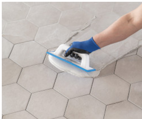
Aanbrengen van Keracolor FF met de Mapei strijkbord
